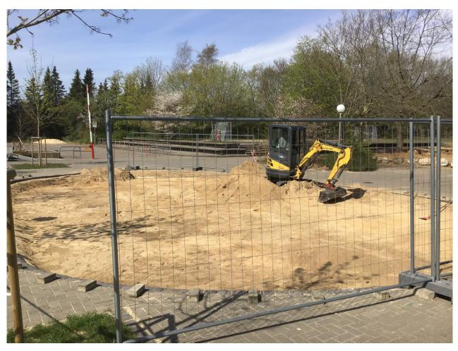
Es wurde ein Minibagger von einem örtlichen Betrieb zur Verfügung gestellt, um die Grube soweit auszuheben, dass der Fallschutz des Klettergerüstes eingehalten werden konnte. Aufgrund der Tiefe der Grube konnte das Oberflächenwasser erfolgreich für die Schulallee genutzt werden (USE 2017-2019).
