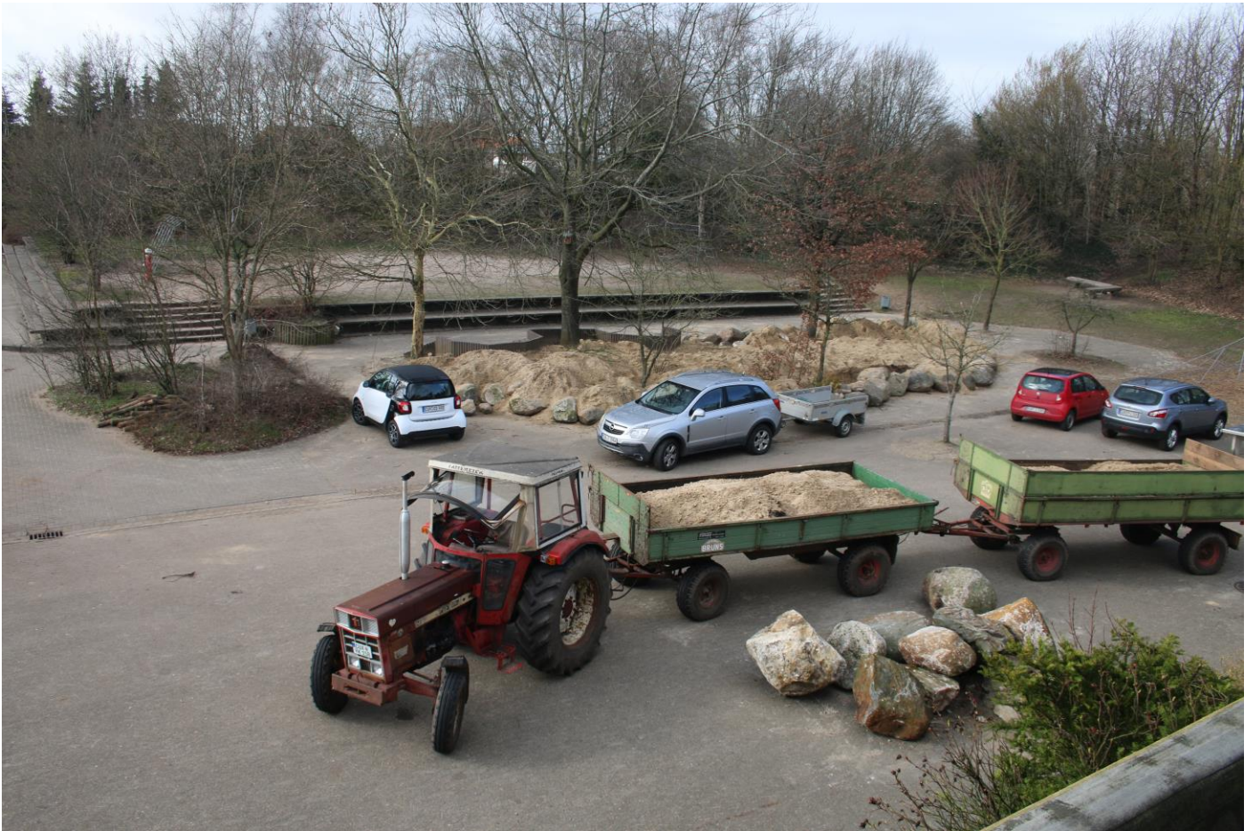
Projekttag am 18.03.2019: Auffüllung des zukünftigen grünen Klassenzimmers mit dem Aushub
