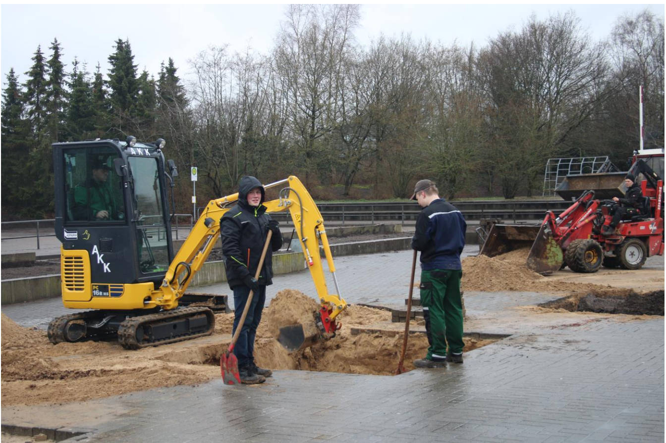
Projekttag am 14.03.2019: Ausbaggern der Pflanzlöcher, Einbringen des Mutterbodens
