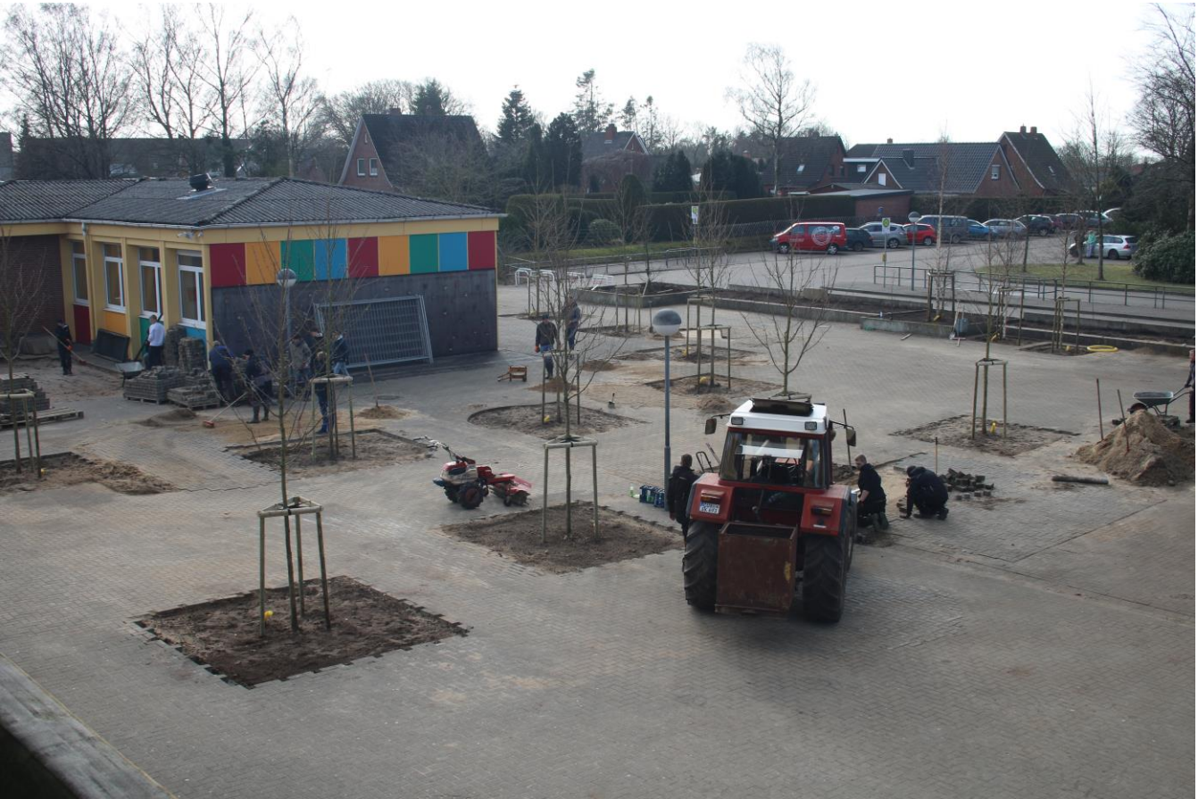
Projekttag am 18.03.2019: Fertigstellung der Pflanzung, Aufräumarbeiten, Anpflastern
