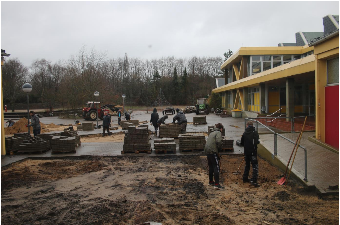
Projekttag am 14.03.19: Entfernung des Bitumenbelags, Aufnehmen des Pflasters an Pflanzstellen
