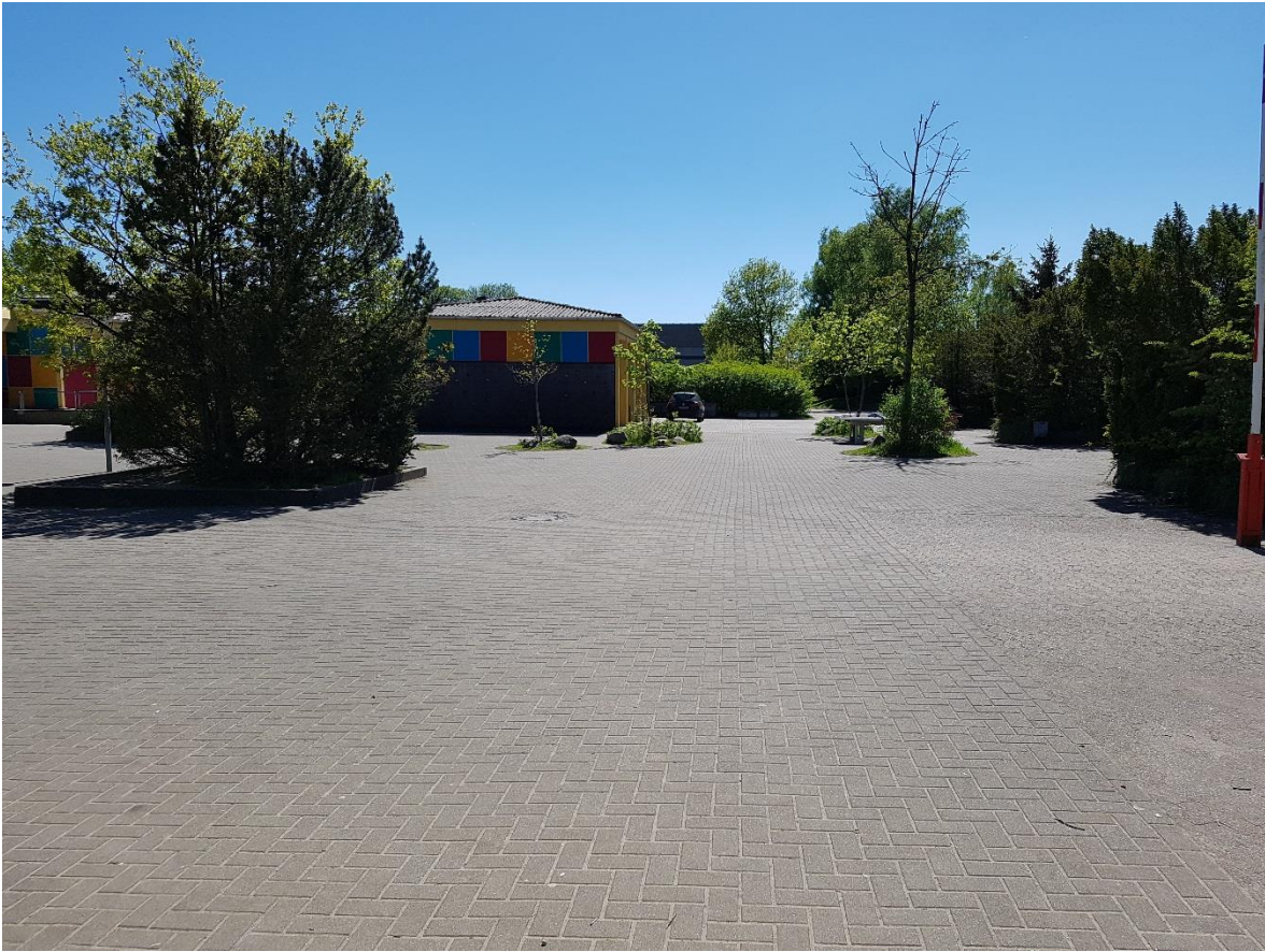
Bild 1: Blick zur Mensa (betoneingefasste Insel links, absterbende Bäume rechts)
