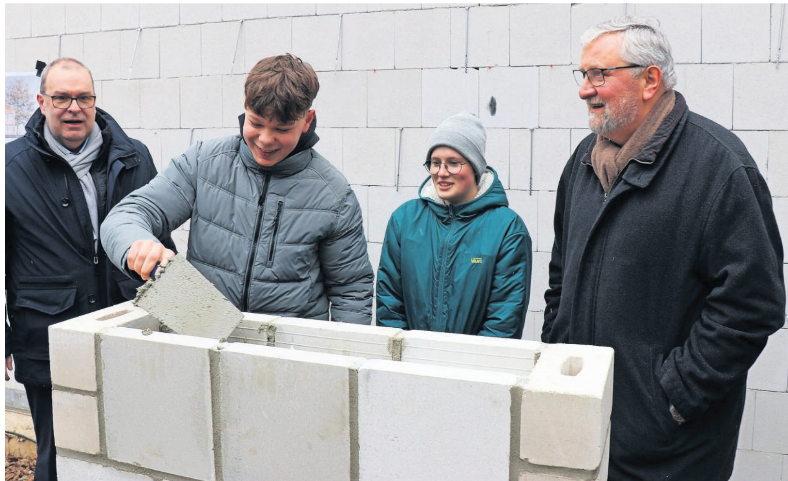
Unter den Augen des Landrats Thorsten Krüger (links) und des Schulausschuss-Vorsitzenden Axel Quast (rechts) griffen die Schülersprecher Jule Rehm (16) und Peer Harms (15) zu Maurerkelle und Mörtel. Foto: Mangels
